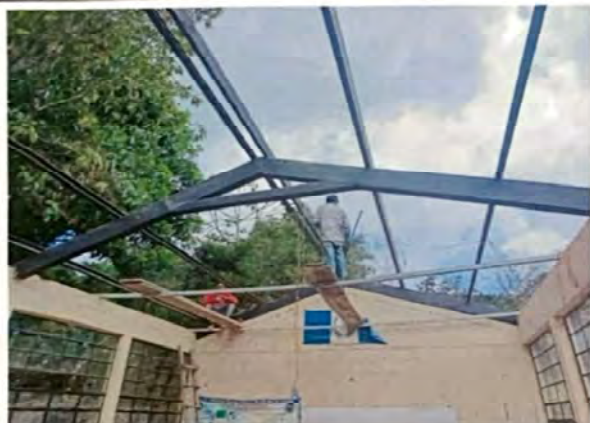
Foto 1: Desmontaje de lamina, limpieza, lijada y pintada de costaneras.
