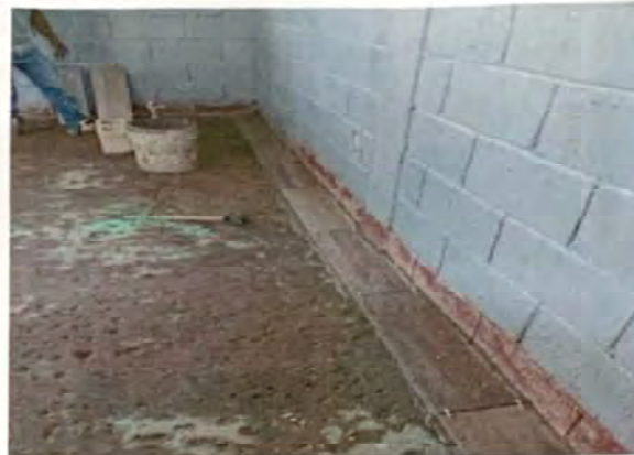
Foto 2: Proceso de colocación de piso nuevo.
